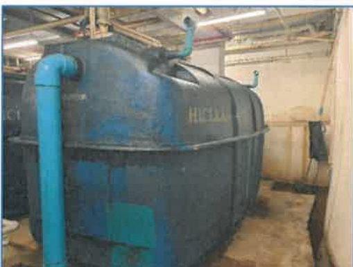
ภาพถ่ายที่ 2.2-4 บ่อกักน้ำทิ้งเพื่อนำน้ำกลับมาใช้
